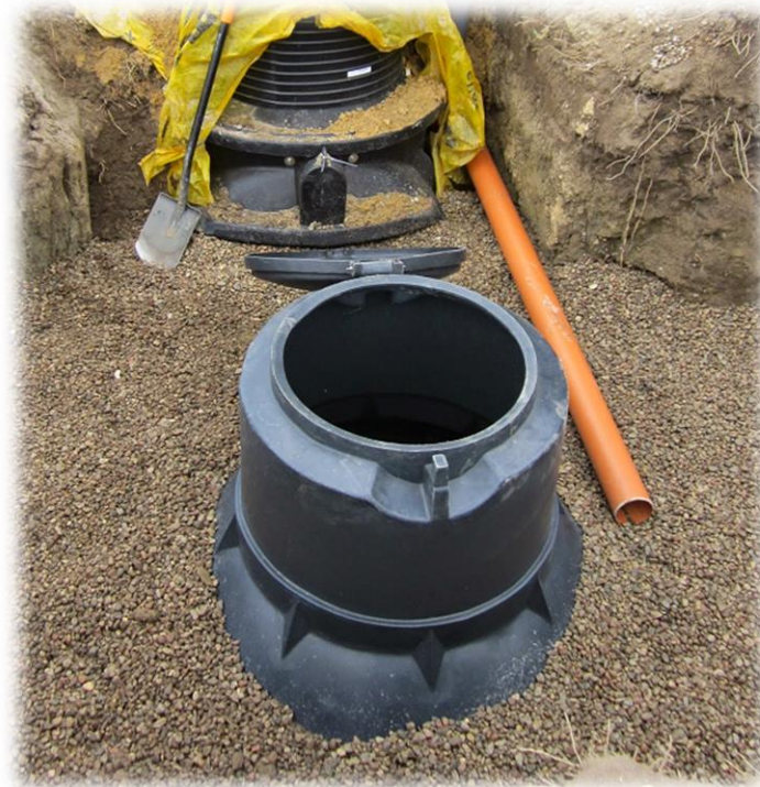
6. Wykonanie studni chłonnej.
