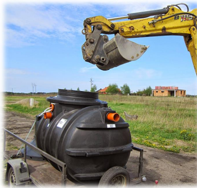
5. Transport zbiornika do wykopu.
