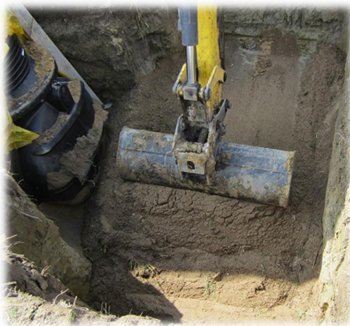
5. Wykonanie wykopu pod studnię chłonną.
