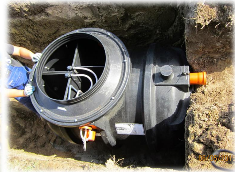
6. Ustawienie i wypoziomowanie zbiornika.
