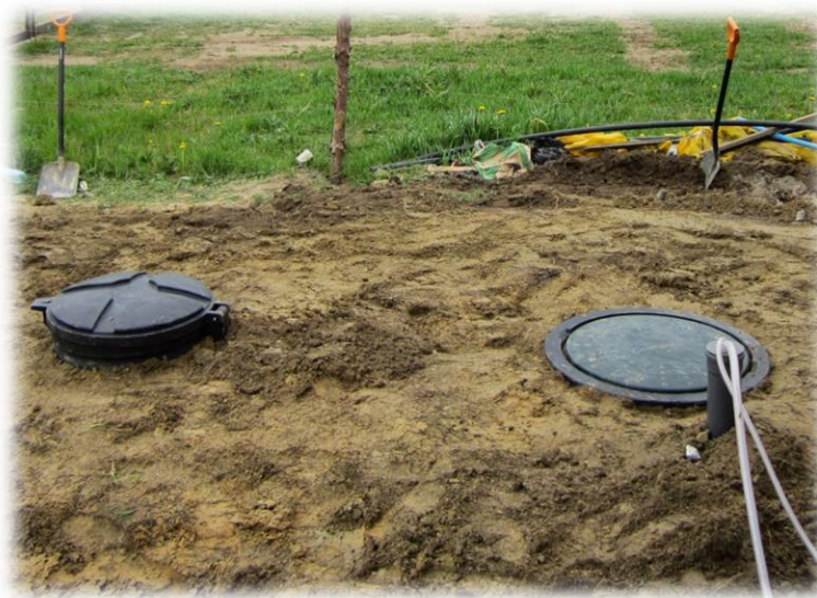
8. Obsypanie zbiornika oraz studni chłonnej.
