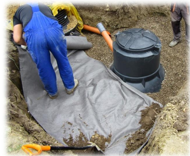
7. Zabezpieczenie geowłókniną.
