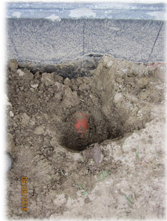
1. Odkopanie rury odpływowej.
