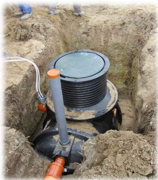
4. Posadowienie i podłączenie rury doprowadzającej ściek.
