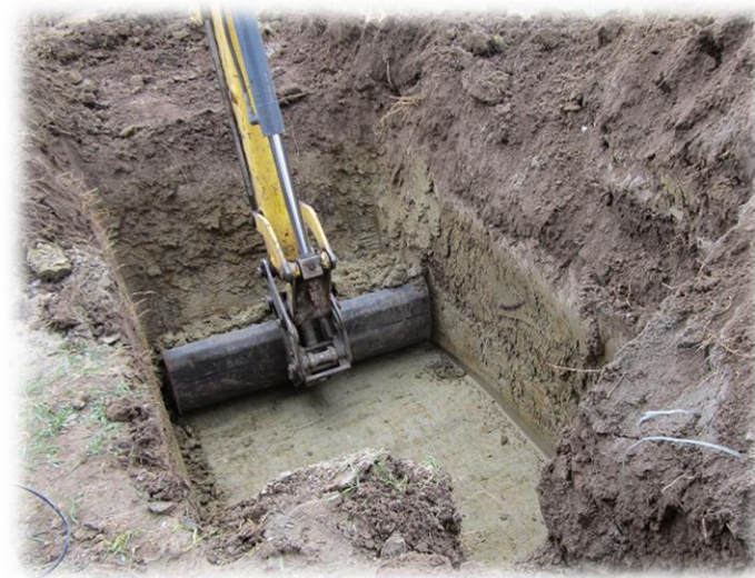
3. Wykonanie wykopu pod zbiornik.
